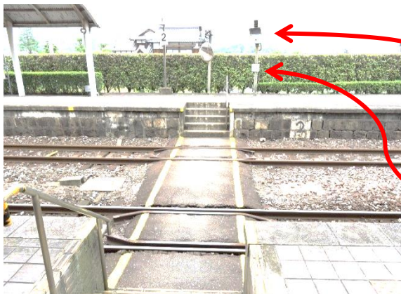
構内旅客通路
