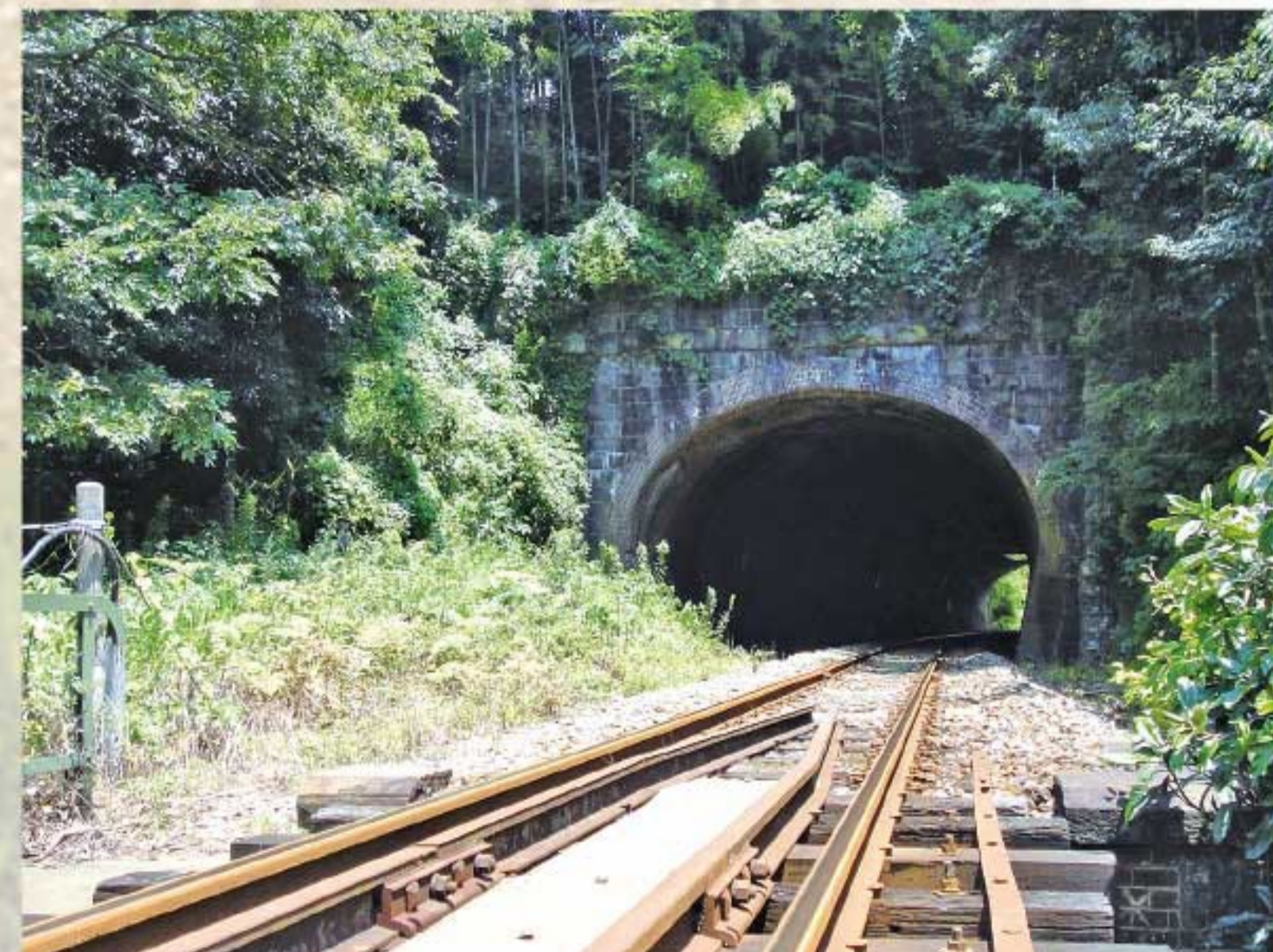
⑪ 第二石坂トンネル 源じいの森駅から約250m 明治28年に行橋～伊田間が開通した当時のトンネルで、第一トンネル33.2m、第二トンネル74.2mと短いトンネルが連続し、九州で最も古い赤レンガのトンネルです。源じいの森の橋の上から見る事が出来ます。
