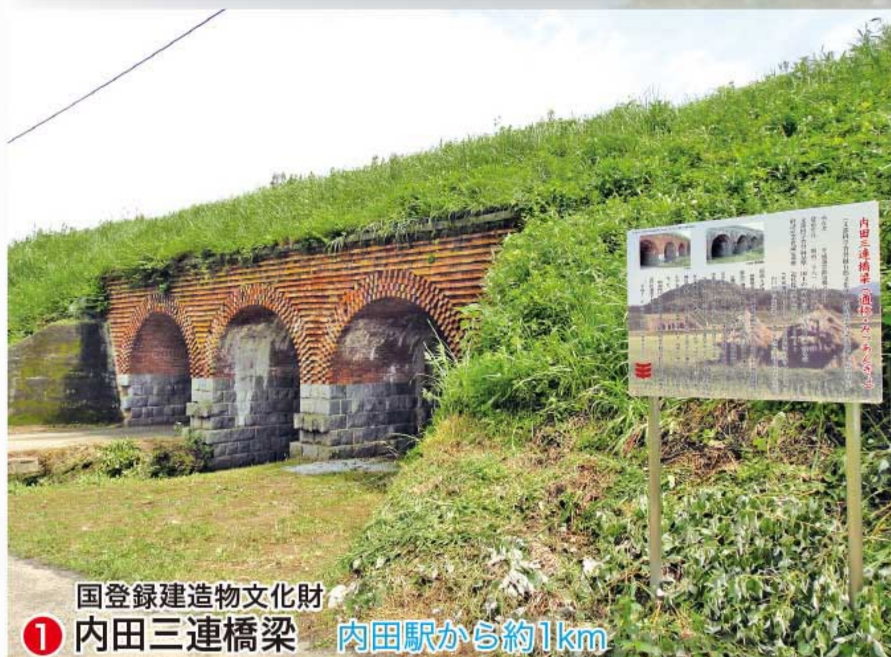
国登録建造物文化財 ① 内田三連橋 内田駅から約1km 明治28年に豊州鉄道によって行橋から伊田間が開通した当時のレンガ造りの鉄道橋で将来の複線化に備えた下駄歯構造の美しい橋梁です。国の登録建造物文化財・経済省認定近代化産業遺産に指定されています。
